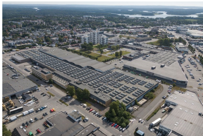
Skanem-tomten: Det tidligere industrianlegget på 55 mål skal forvandles til et nytt og urbant boligområde.
