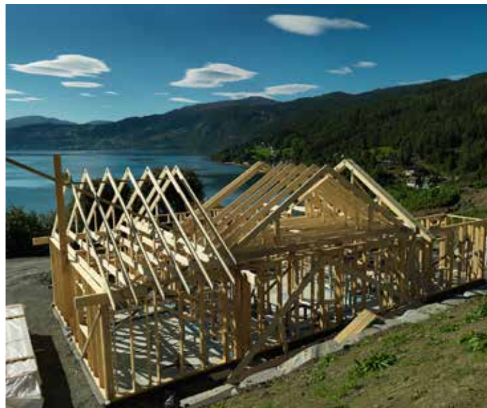
Skreddersydd: Pretre tilbyr skreddersydde løsninger slik at kunden slipper ytterligere tilpasninger under montering. Desto større ferdigstillelsesgrad fra fabrikk, desto raskere går arbeidet på byggeplassen. Foto: Pretre
