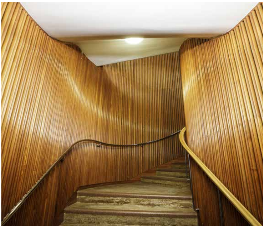
STEG FOR STEG: Trappeløpet inn til Store Studio er et av de vernede elementene som vil bevares, også når bygget moderniseres. Foto: Nyebilder
